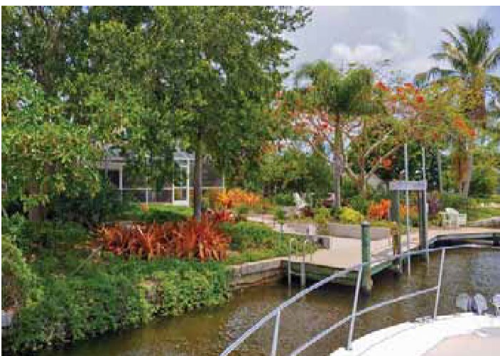
Los malecones pueden ayudar a minimizar la erosión de la costa, pero pueden causar otros problemas.
