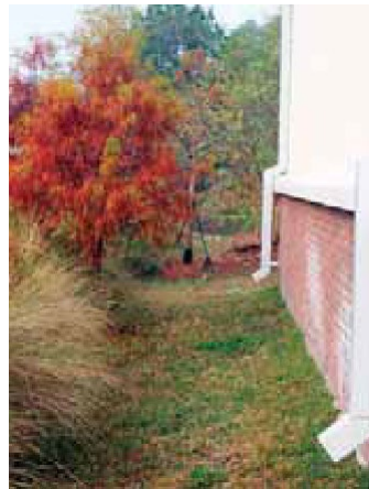
Dirija las bajantes hacia las áreas porosas, incluidos los jardines infiltrantes.
